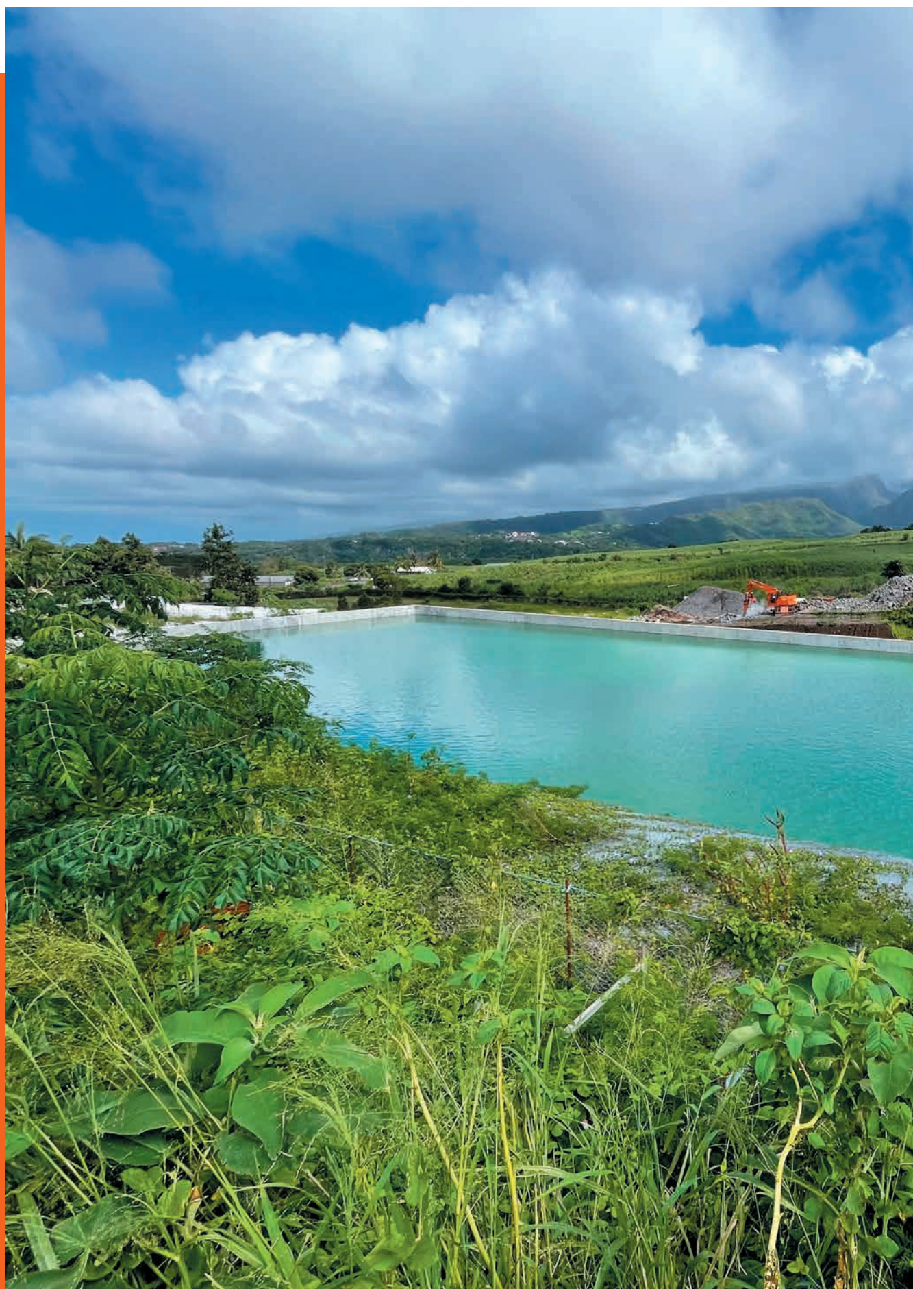
Nouveau réservoir de Dassy de 20 000 m 3
