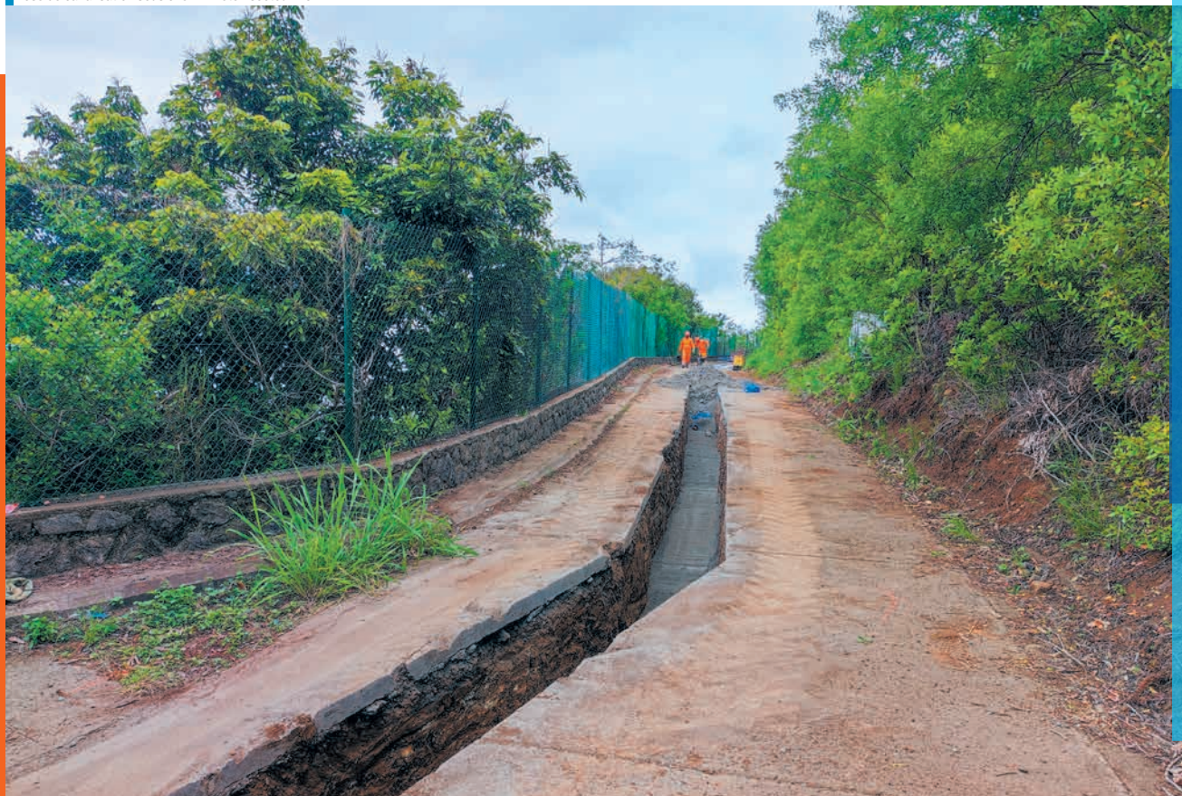
Pose de canalisation sous chemin Béton secteur BC1
