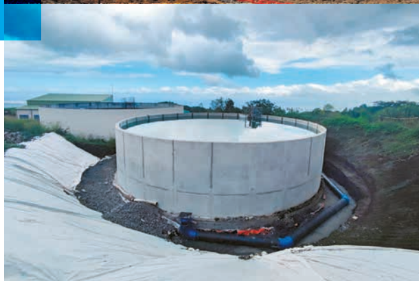
Essai en eau du réservoir Mouchoir Gris 2 secteur BC1 Saint-Louis
