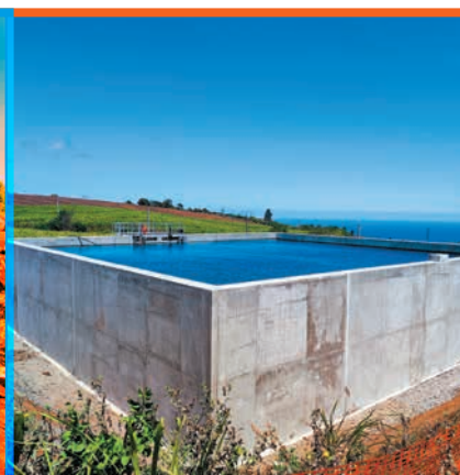
Réservoir BP3 Bérive en eau
