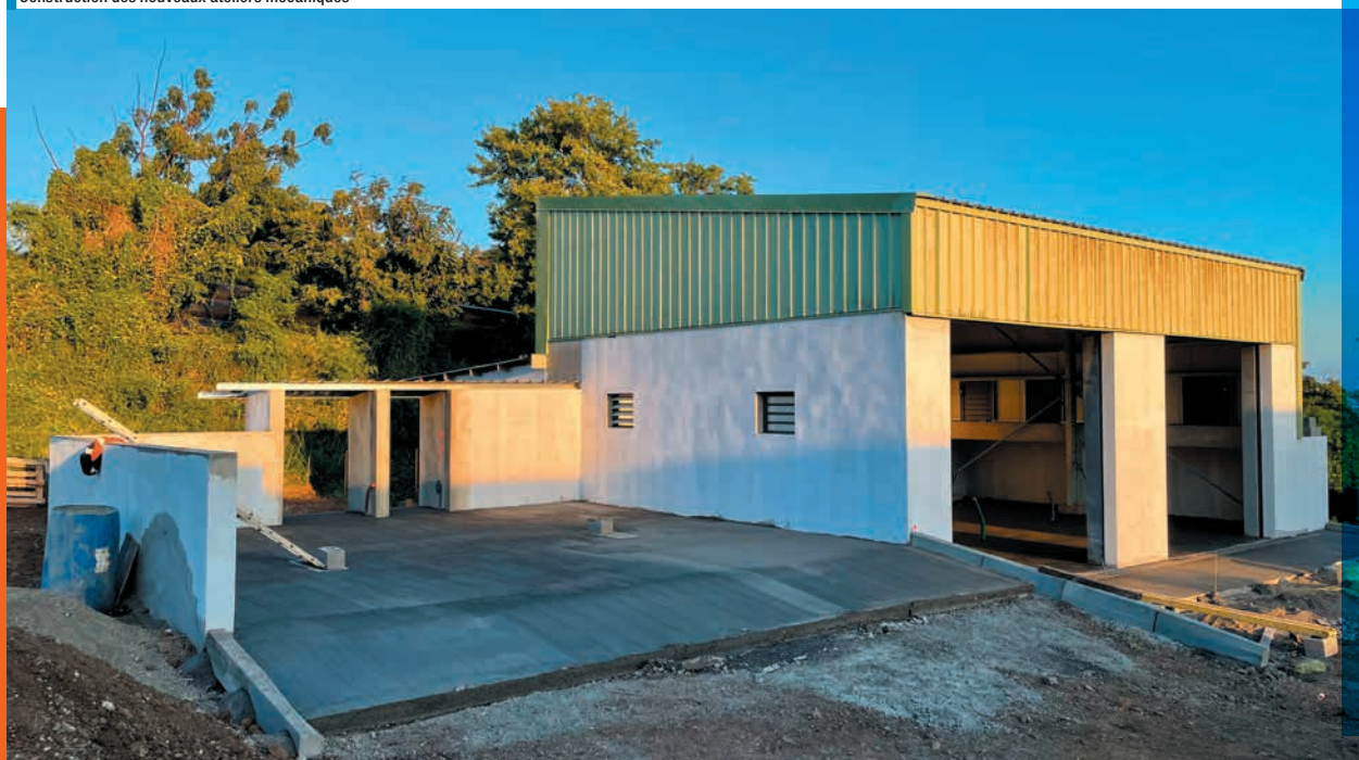
Construction des nouveaux ateliers mécaniques
