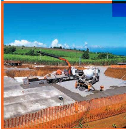
Coulage du radier réservoir BP3 Bérive
