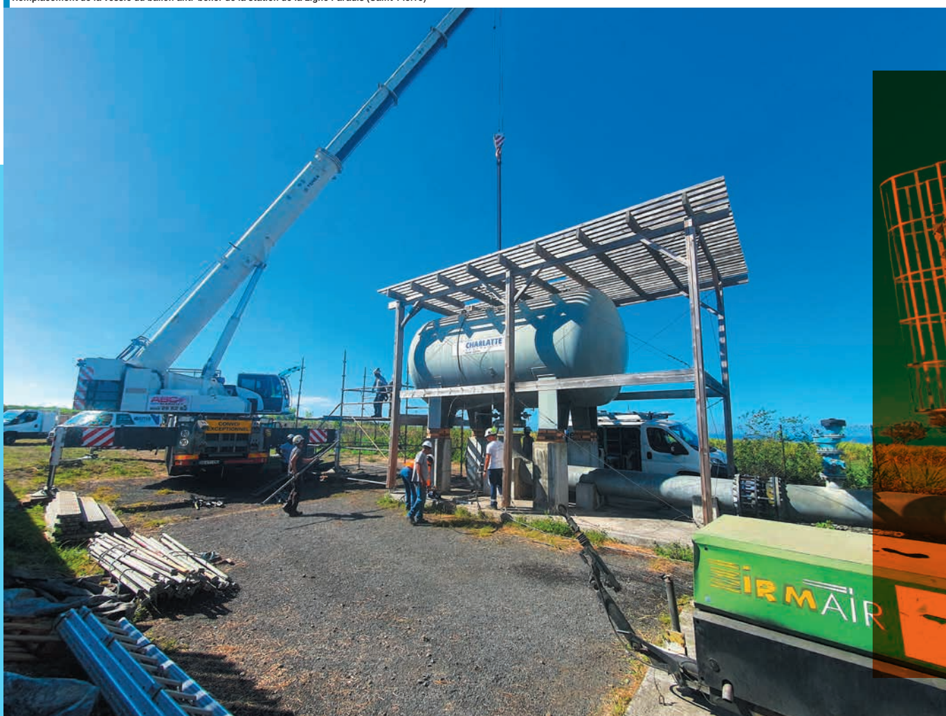
Remplacement de la vessie du ballon anti-bélier de la station de la Ligne Paradis (Saint-Pierre)
