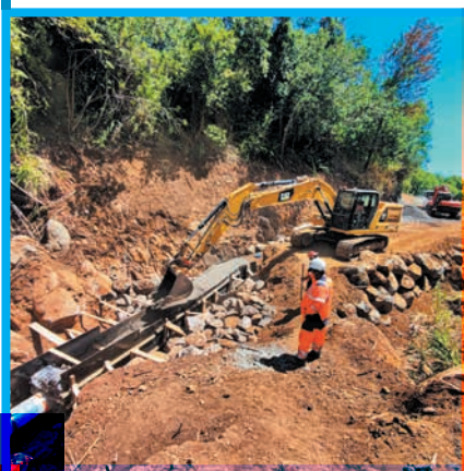
Pose de canalisation au niveau de la ravine Bassin Martin BP
