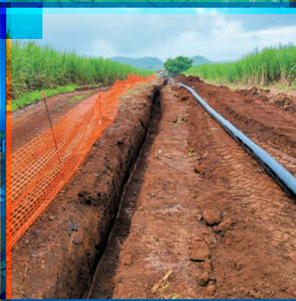
Pose de canalisation PEHD BP3 Bassin Martin
