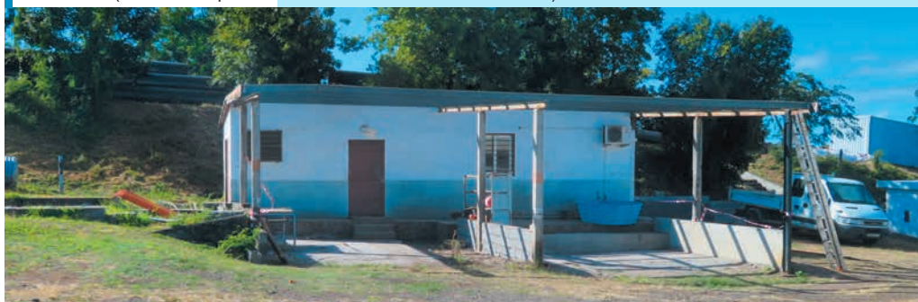
Travaux en cours (démolition d'une partie de l'existant et construction de la nouvelle structure)
