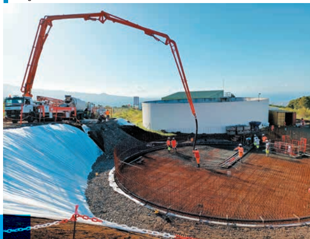
Coulage du radier réservoir Mouchoir Gris 2 secteur BC1 Saint-Louis
