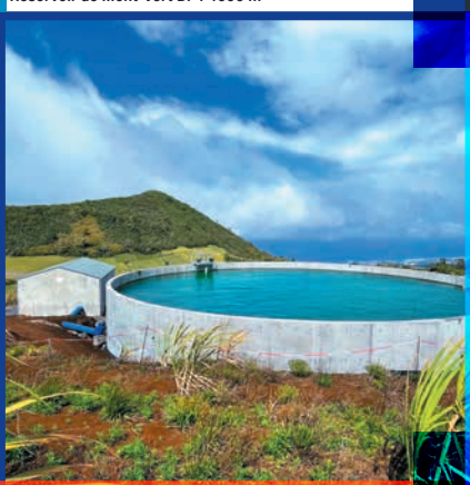
Réservoir de Mont-Vert BP4 4000 m 3
