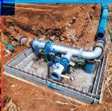
Pose du refoulement DN500 BP4 Mont-Vert
